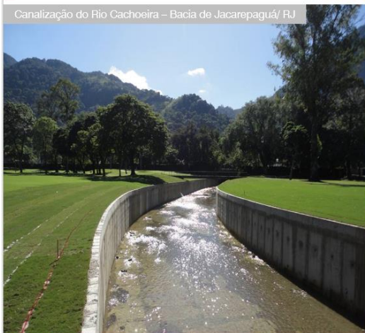
Canalização do Rio Cachoeira – Bacia de Jacarepaguá/ RJ
