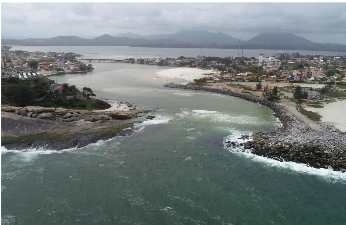
Figura 1 - Imagem mostrando o molhe danificado a direita e o canal assoreado em toda sua extensão
